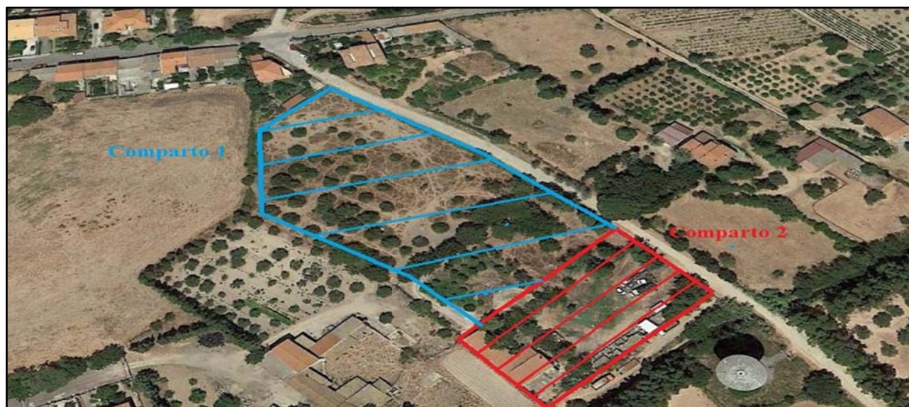
Figura 1 – Stralcio estratto da Google Earth della zona di intervento.
