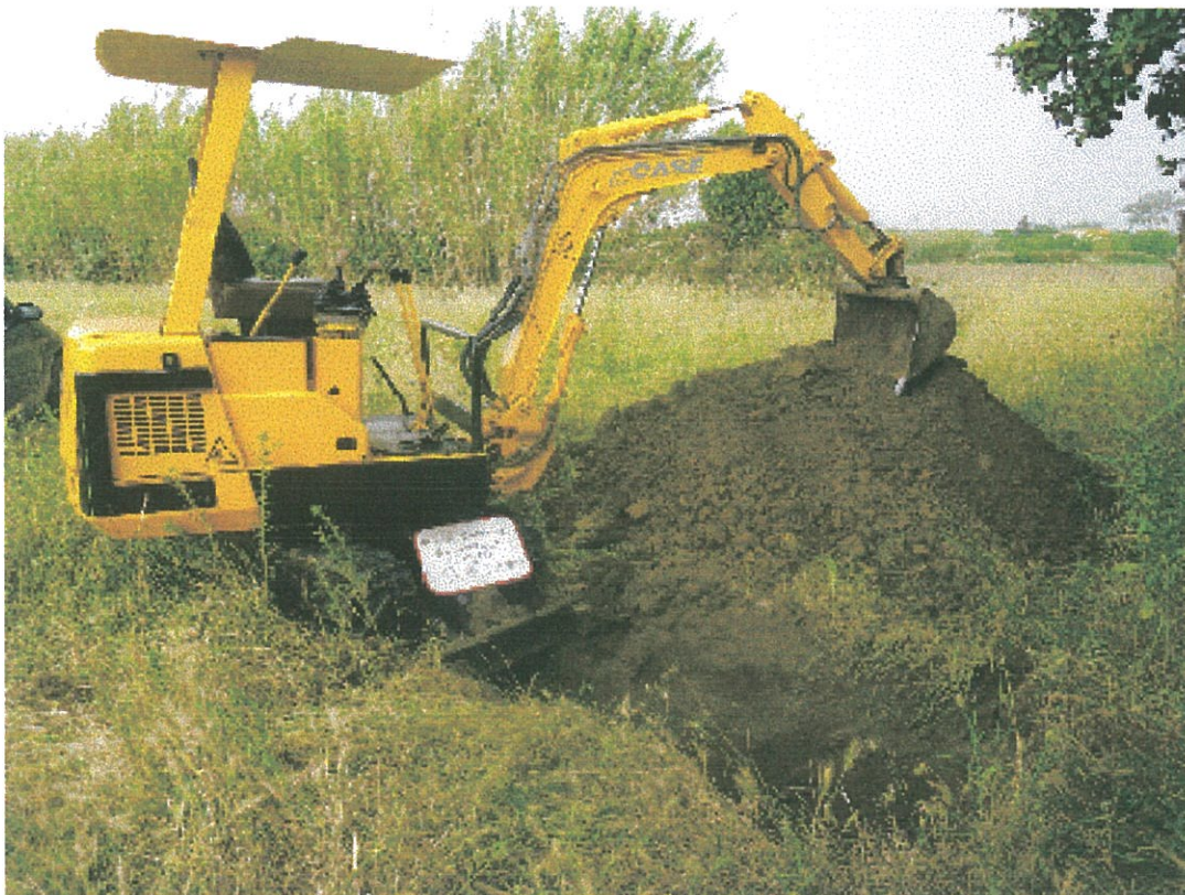
Pozzetto geognostico Pz.2
