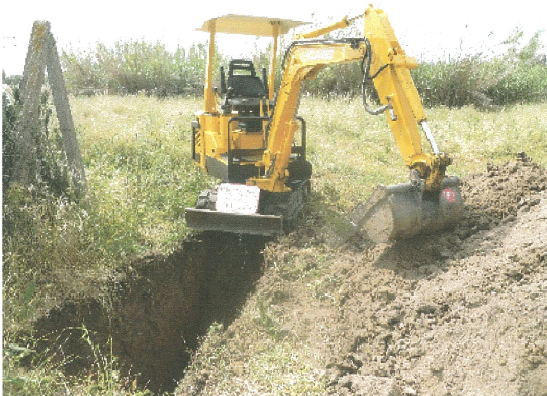
Pozzetto geognostico Pz.3
