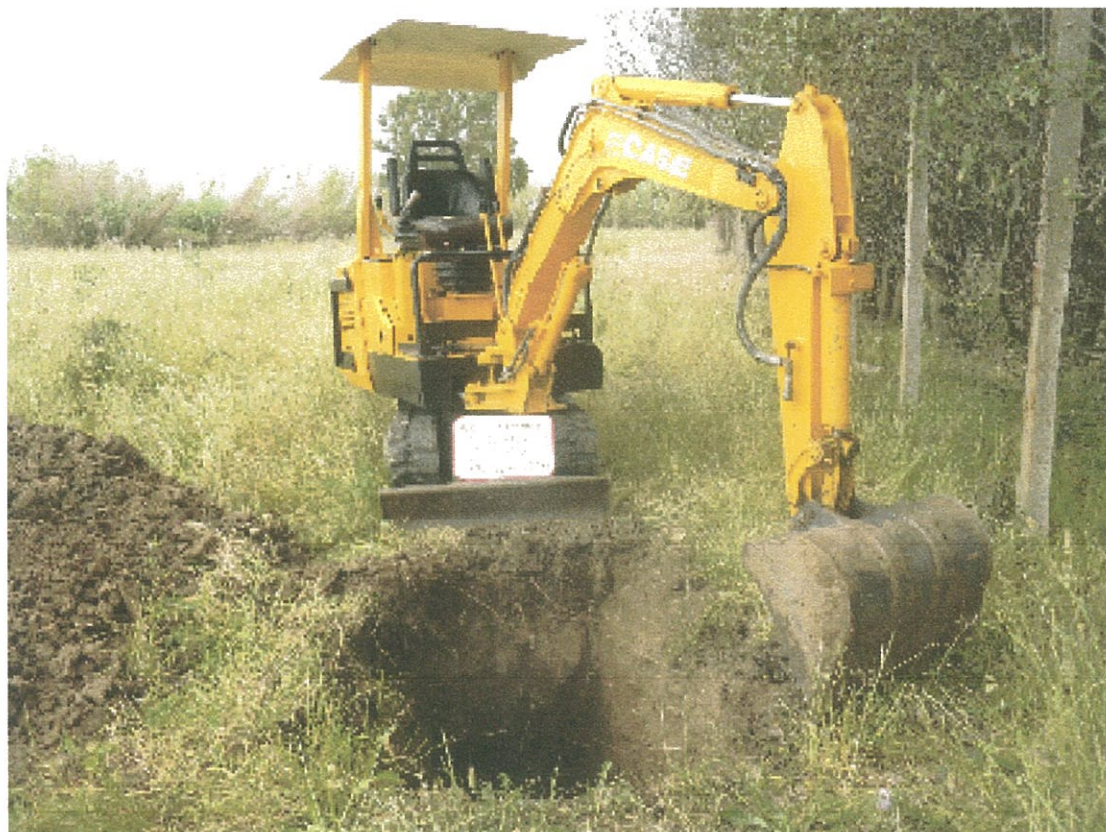
Pozzetto geognostico Pz.4
