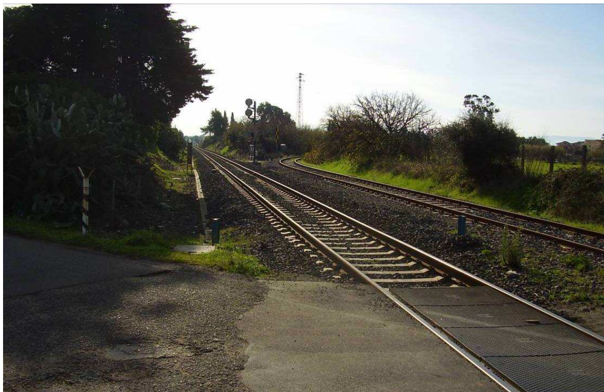
Foto 6: Particolare linea ferroviaria esistente (n. 1 direzione Cagliari e n.1 deviazione per area industriale di Oristano)
