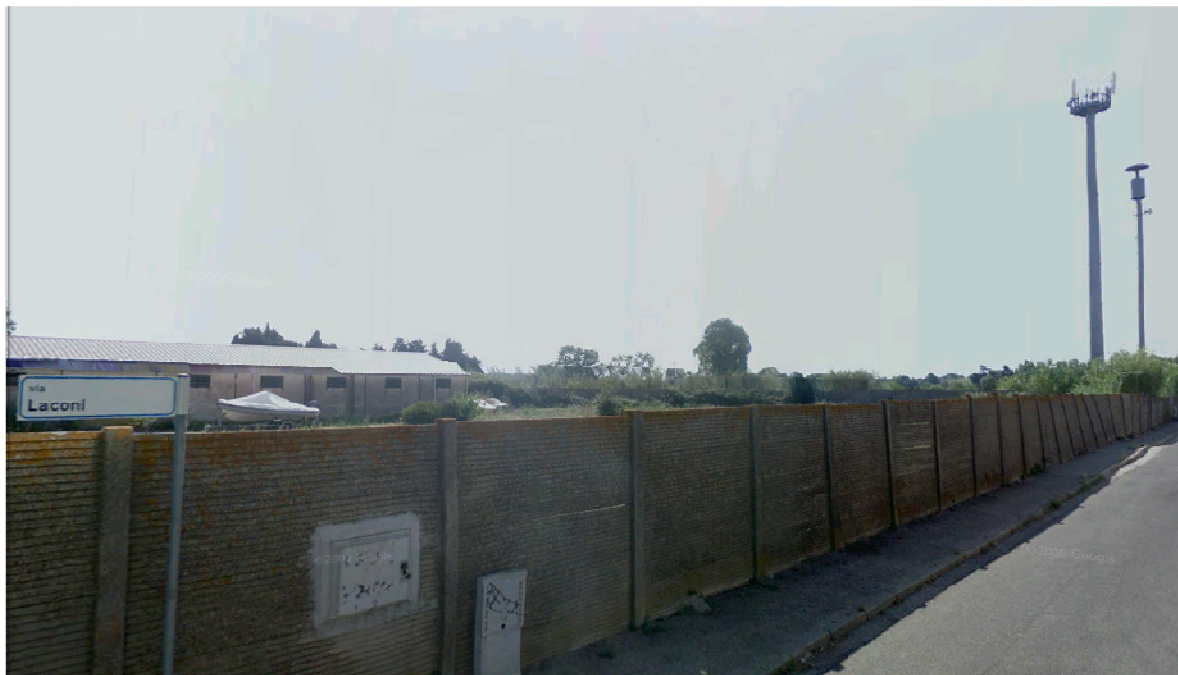
Foto 3: Vista su Via Laconi (particolare pali di telefonia e aree in edificate esistenti)
