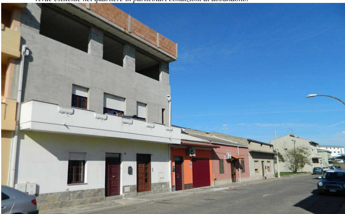
Foto 10: Vista su Via Isili (direzione nord verso Via Laconi)- Particolare fabbricati di maggiore altezza presenti nel contesto.
