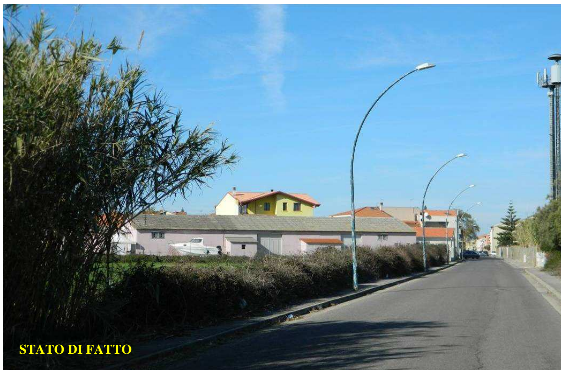
Foto 11-A: Vista reale su Via Laconi (direzione dal passaggio a livello verso Oristano)
