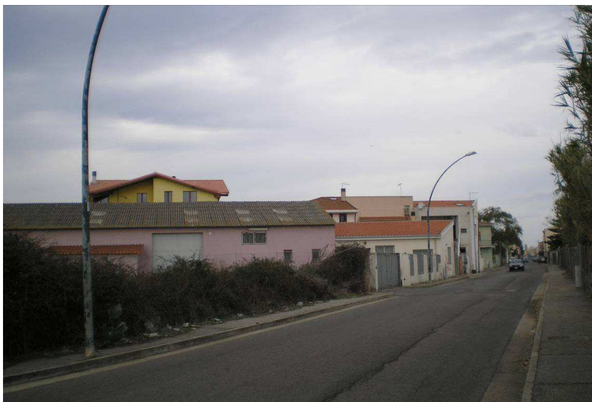
Foto 4: Vista su Via Laconi (particolare ultimi lotti edificati esistenti)
