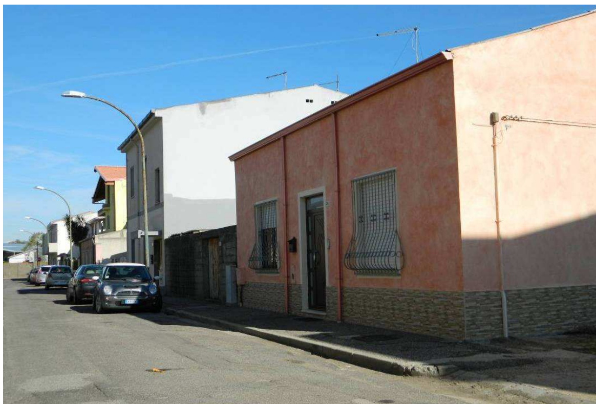
Foto 8: Vista su Via Isili (direzione nord verso Via Laconi)
