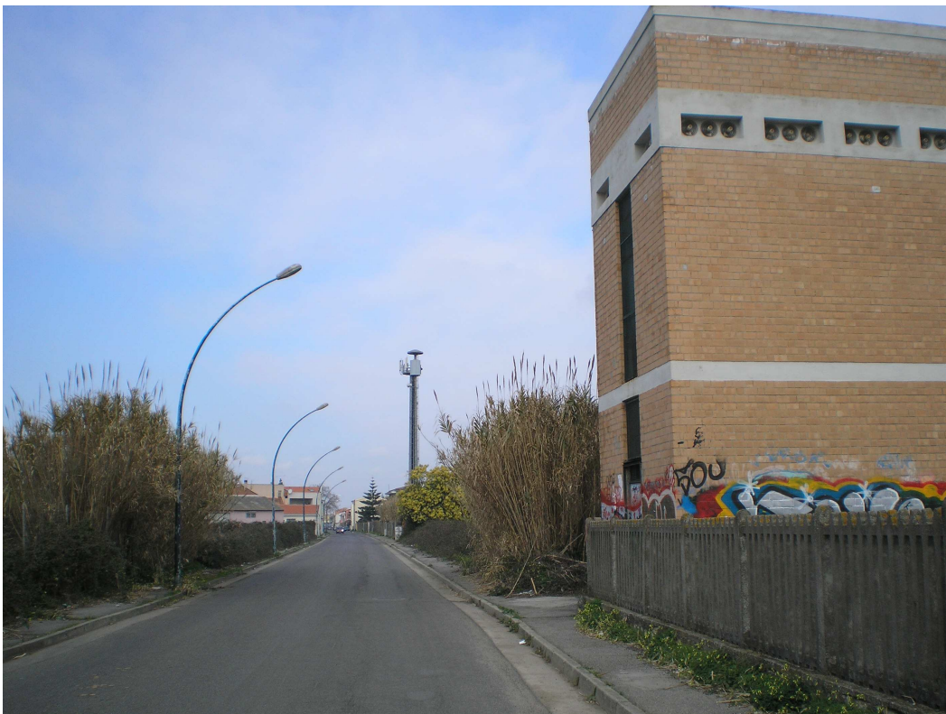
Foto 8: Particolare cabina elettrica esistente su Via Laconi.
