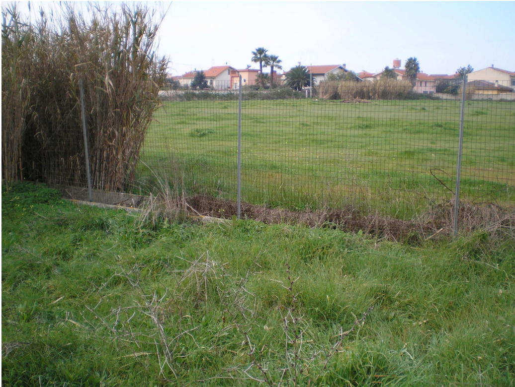
Foto7: Particolare confine est dell'area di intervento (canaletta in cls in disuso)
