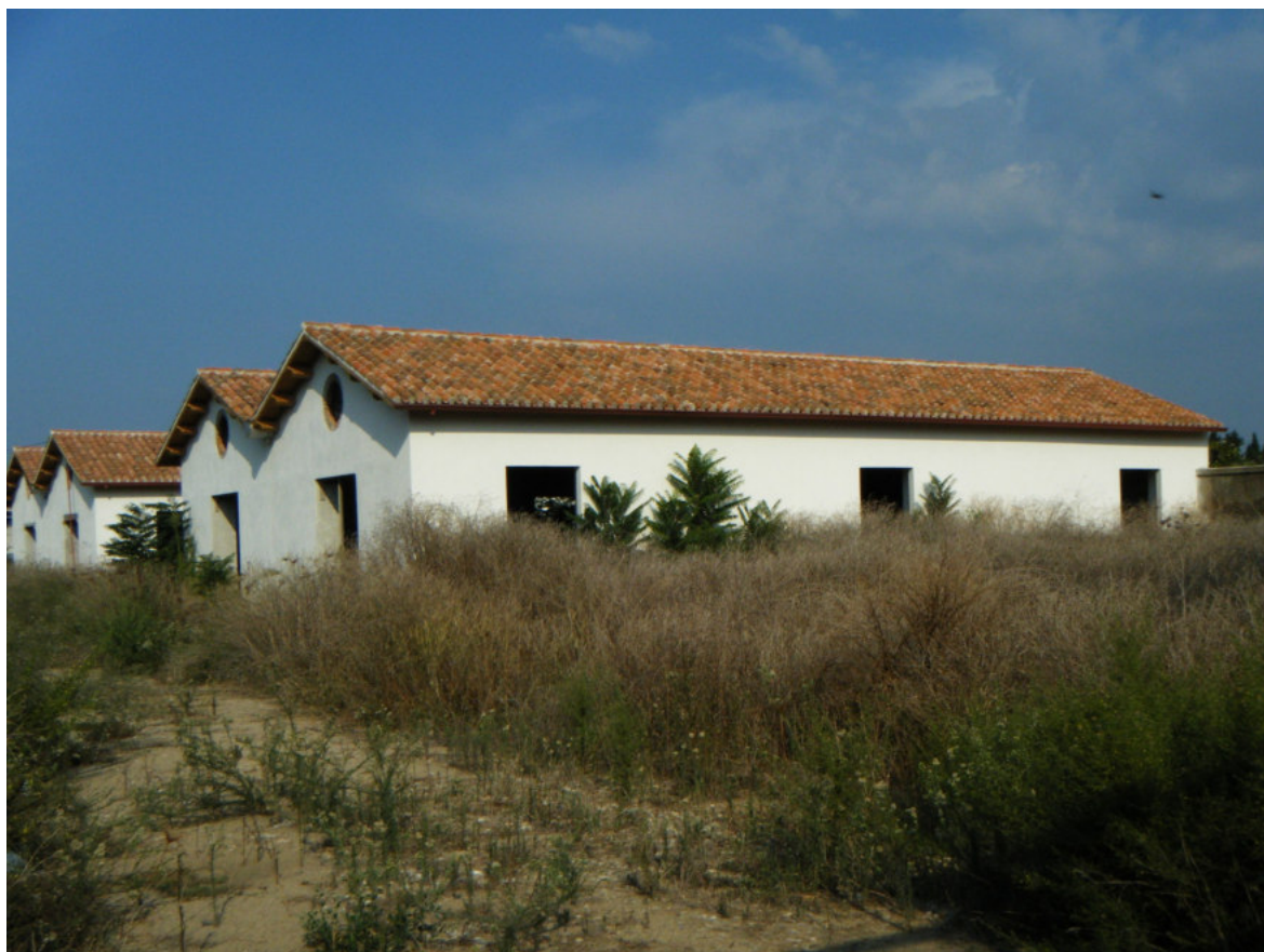
Foto 3 - Capannoni F e G
