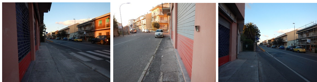
Figura 8 Viste dello stato di degrado dei marciapiedi e vista della pista ciclabile in Via Casu
