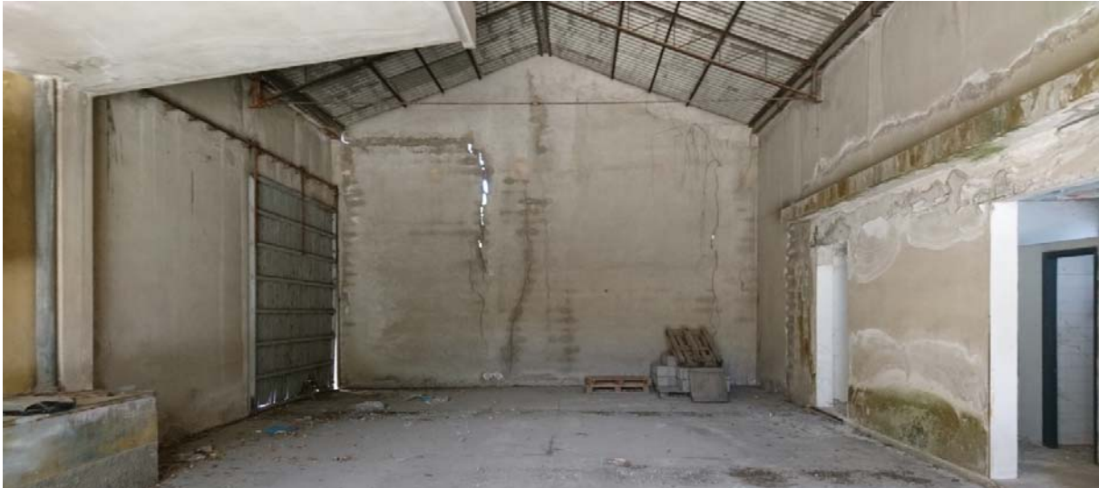
Figura 2: Il capannone di collegamento tra essiccatoi e palazzina alloggi, vista interna
