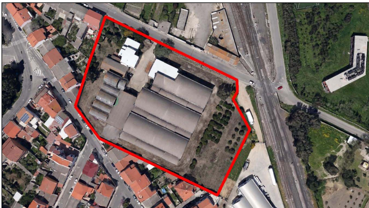
Figura 2. Vista aerea dello stato attuale della struttura.
