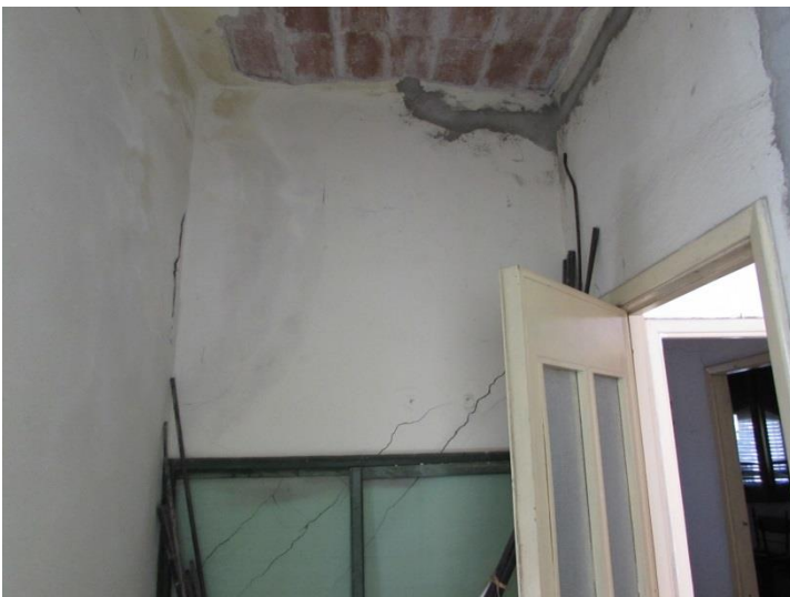
4- l'intradosso del solaio di copertura
