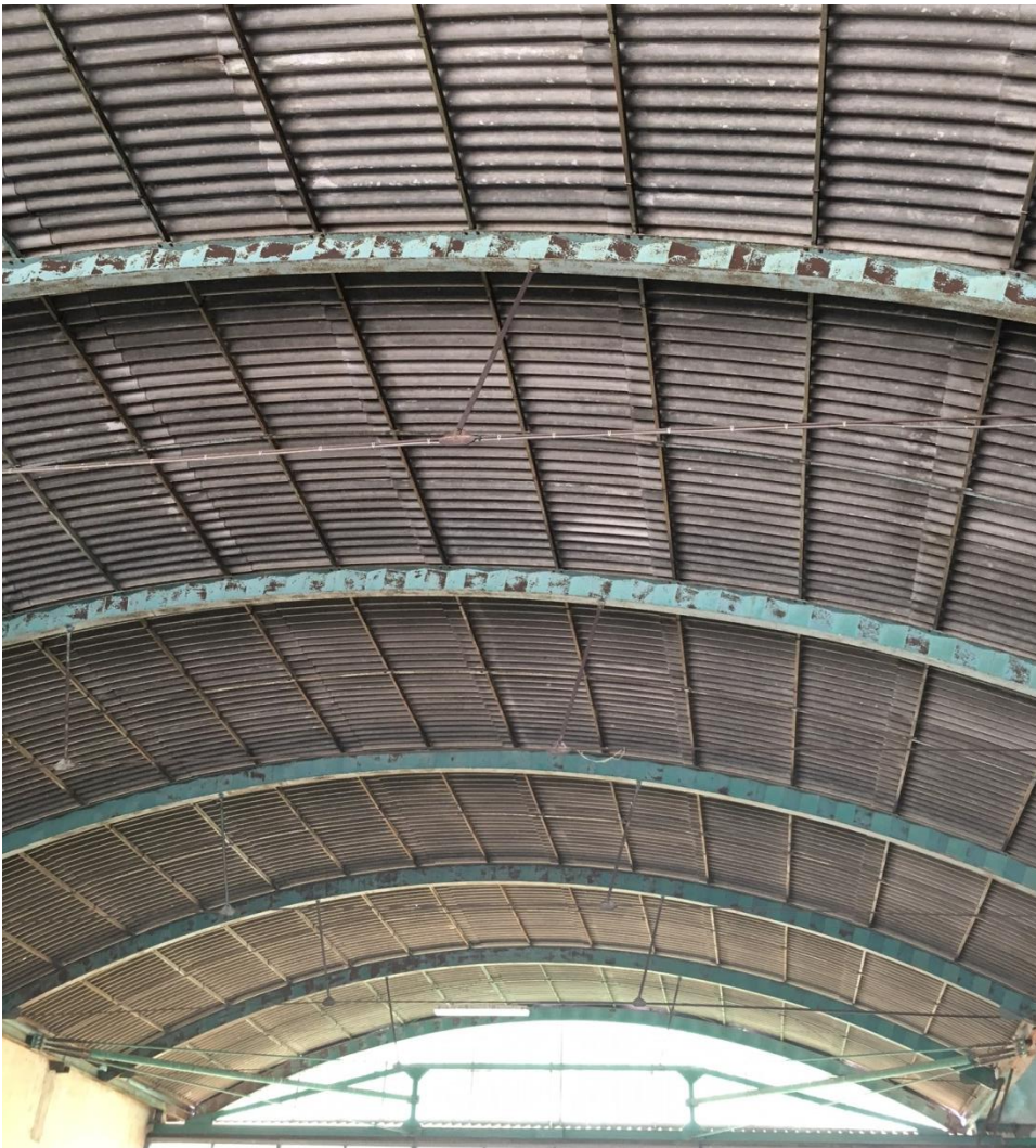
12 - vista dell'intradosso della copertura di collegamento tra stoccaggio e lavorazione
