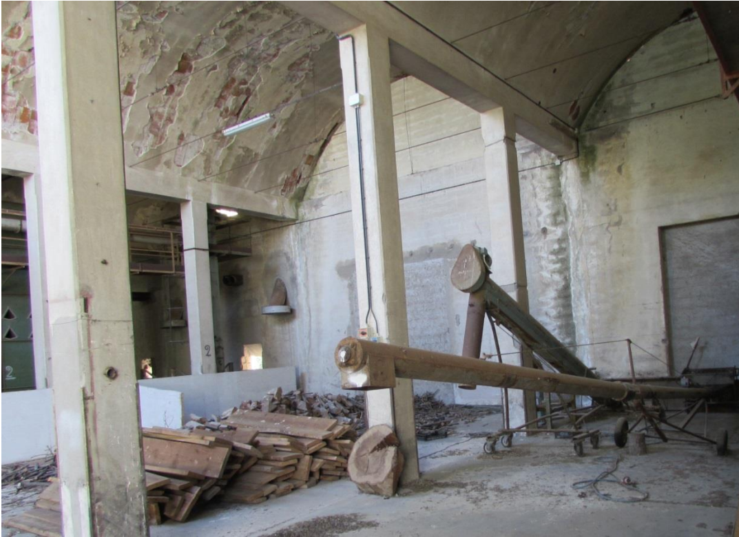
10 - Vista interna tra il secondo e il terzo capannone
