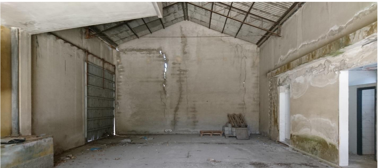
8- il capannone di collegamento tra essiccatoi e palazzina alloggi, vista interna
