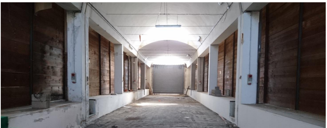
14 - una delle gallerie di distribuzione dei magazzini di stoccaggio
