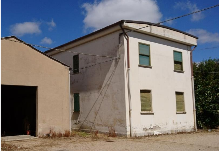
5- Il muretto d'attico modificato per accogliere il manto in pannelli sandwich
