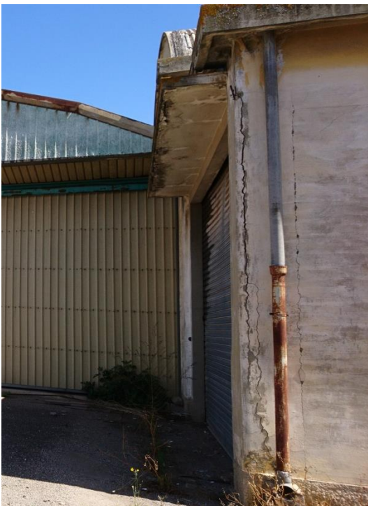
17 - pilastro d'angolo della galleria a sudovest
