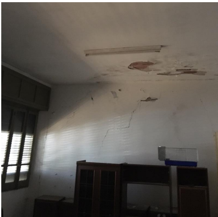
2- soffitto di un vano uffici al piano terra
