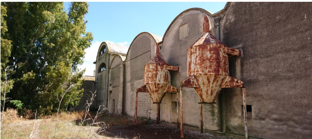
9 - Vista esterna del lato nordovest della sequenza dei capannoni
