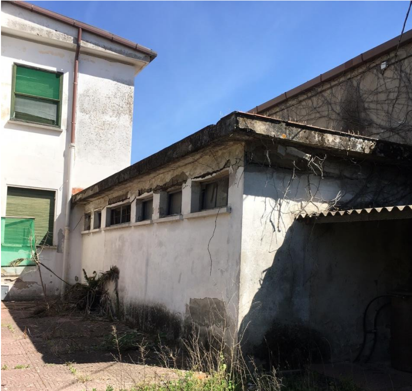
7 - Il corpo bagni vista esterna
