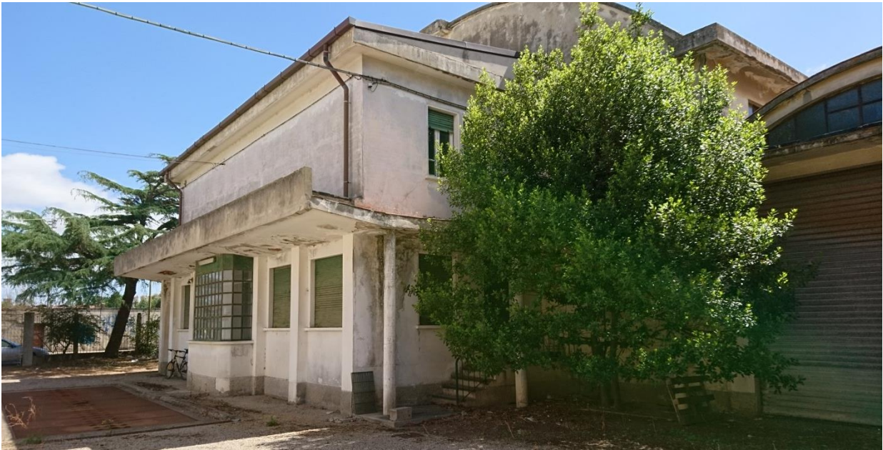
16 - La palazzina uffici vista da nordovest
