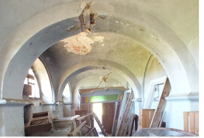
Piano terra_Corpo longitudinale, lato sud-est
