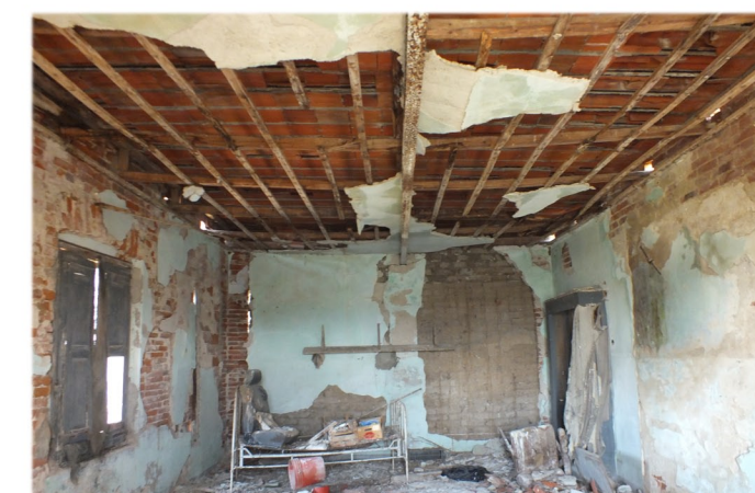
Piano secondo-terrazza_Superfelazioni novecentesche
