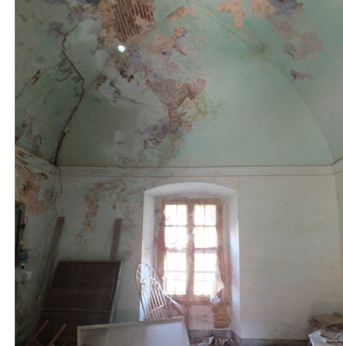
Piano primo_Sala centrale
