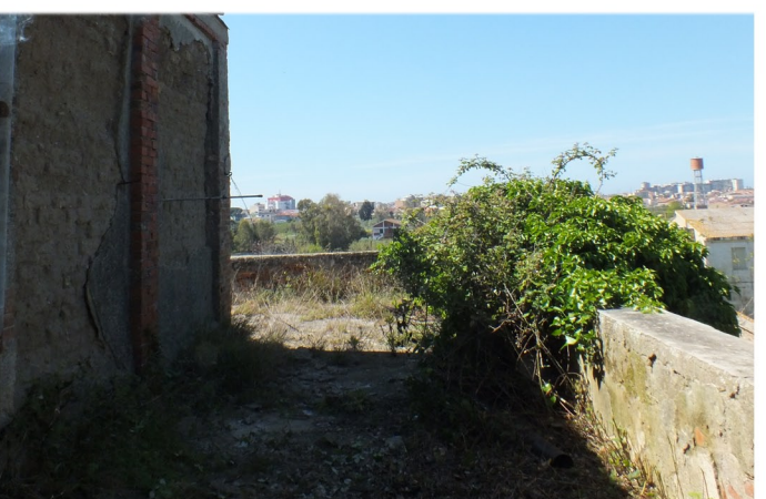
Piano secondo-terrazza_Superfelazioni novecentesche
