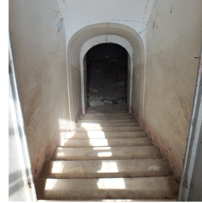
Piano terra_Scalone monumentale
