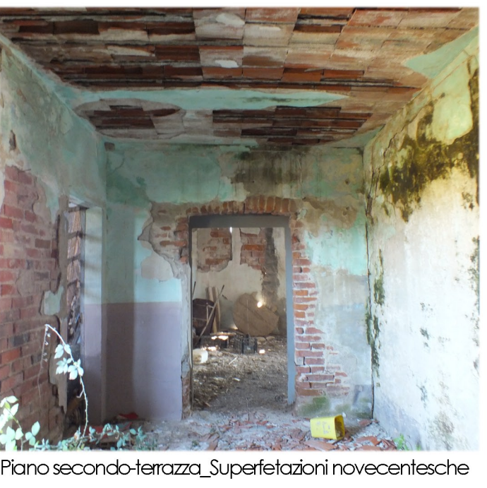
Piano secondo-terrazza_Superfelazioni novecentesche
