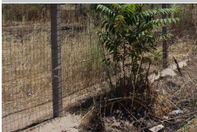
Cordolo di fondazione in cls
