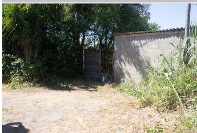
Muro in blocchi di cls
