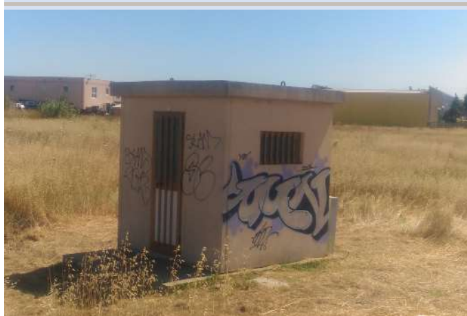
Cabina ferroviaria in muratura
