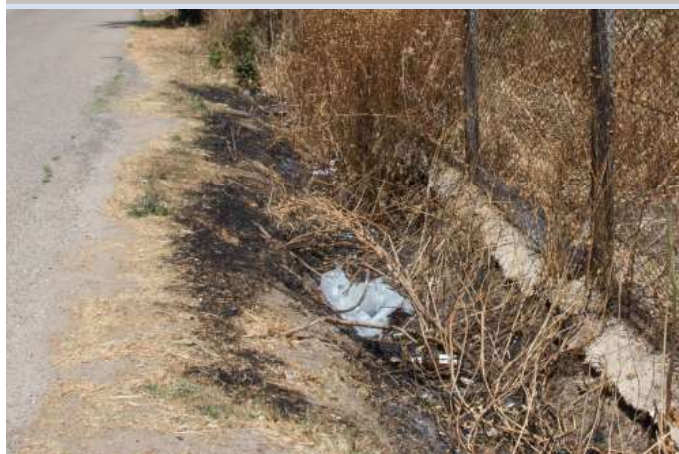
Canale di scolo - cunetta
