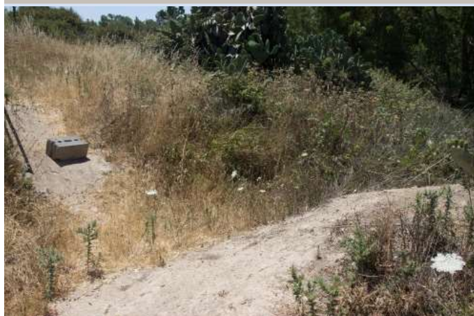
Canale di scolo con getto in cls
