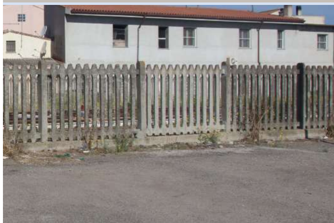
Recinzione prefabbricata in cls
