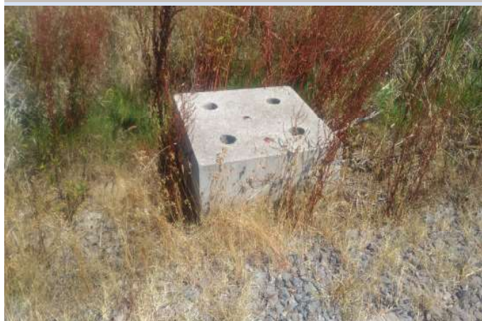
Fondazione cls per vvpali e semafori
