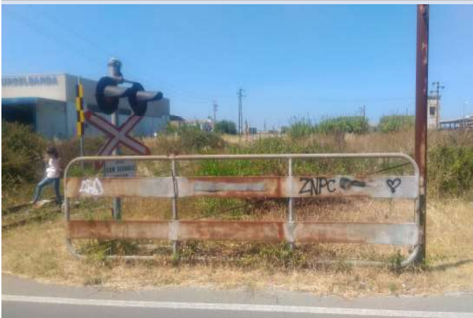
Cancello passaggio a livello ferroviario
