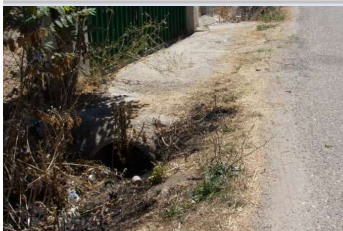
Canale coperto tubolare in cls
