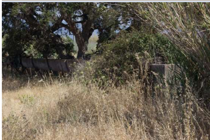
Canale adduttore in cls
