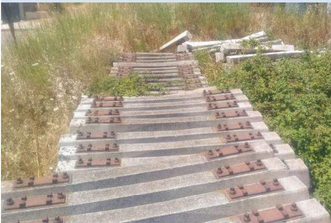
Traversine ferroviarie in c.a. e ferro
