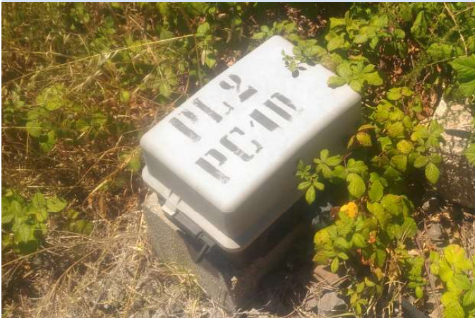
Centralina elettrica di frenata
