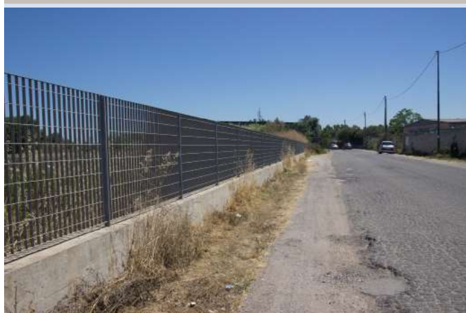
Muro in cemento armato
