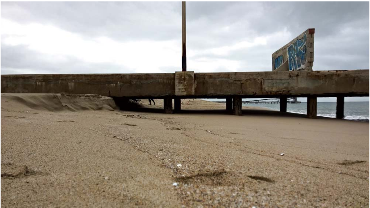
Foto – Settore litorale apparentemente stabile tra Torregrande e la foce del Tirso, al Pontile Dogana
