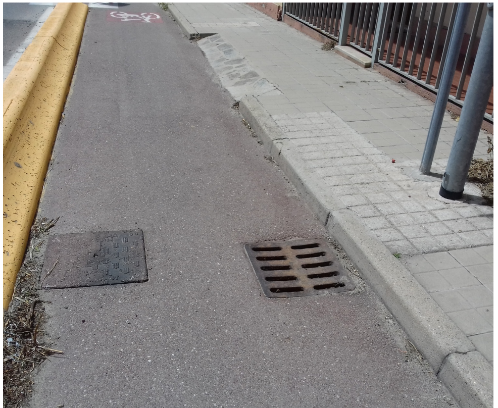
L'attuale posizione di griglie e pozzetti in coincidenza con il tracciato della pista ciclabile.
