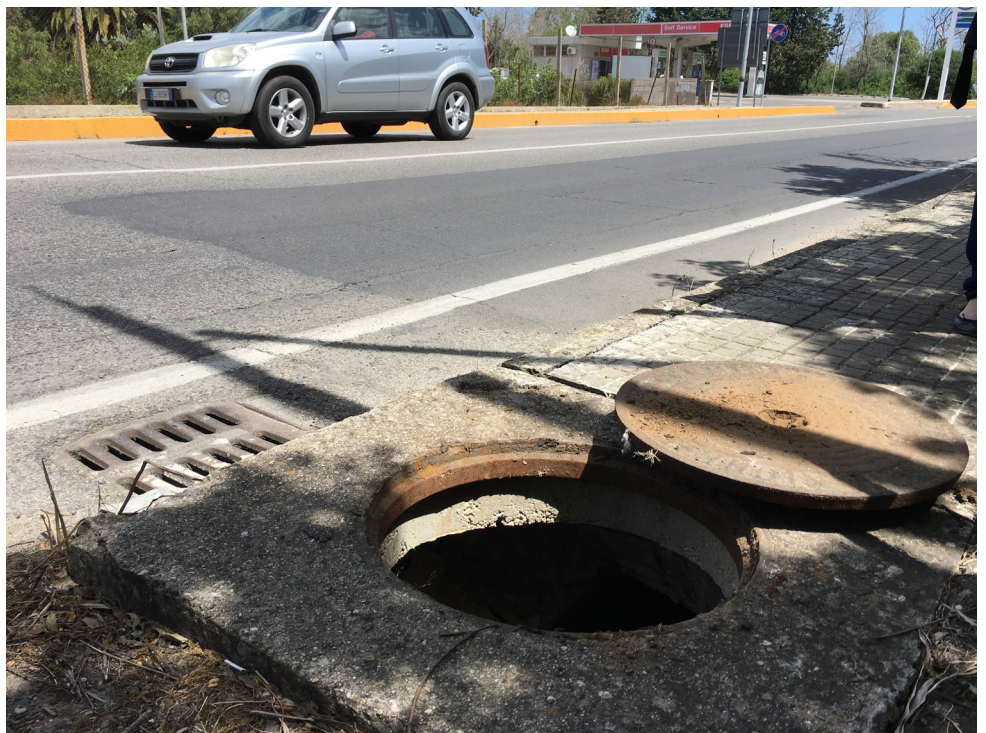
Il pozzetto realizzato in corrispondenza dell'inversione degli impianti di smaltimento delle acque meteoriche e di illuminazione pubblica da un lato all'altro della strada.
