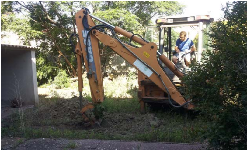
Figura 18. Esecuzione del pozzetto 1 mediante terna gommata.
