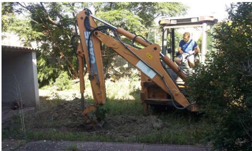
Figura 6. Esecuzione del pozzetto 1 mediante terna gommata.
