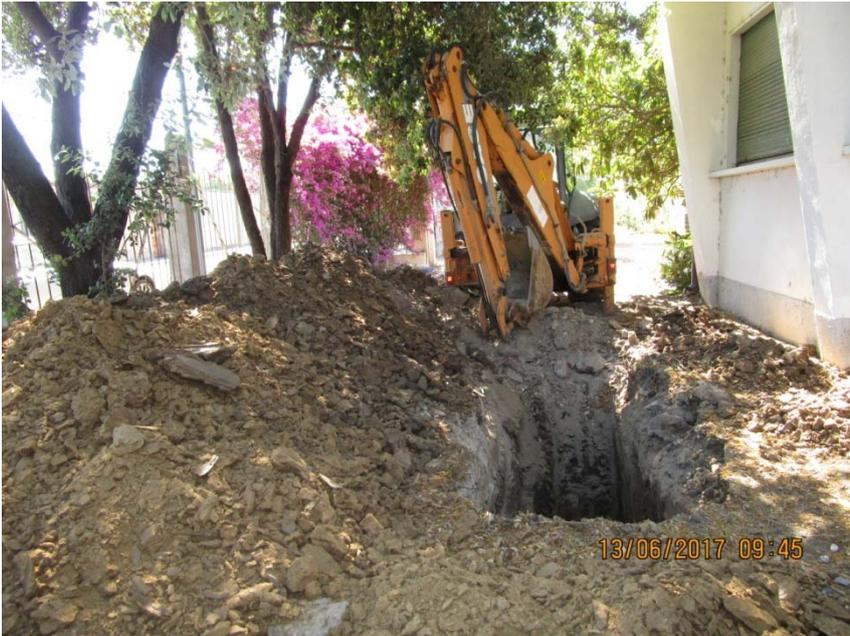
**Foto n.3:** Pozzetti di ispezione - fase di scavo
