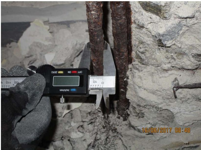
**Foto n.10:** Indagini su pilastri in c.a. - misurazione del diametro delle armature
