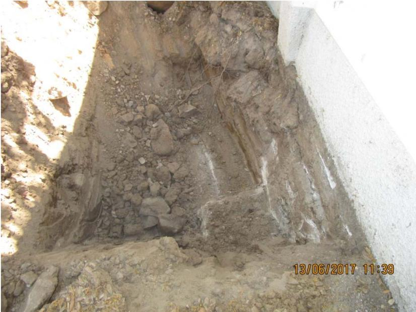
**Foto n.7:** Pozzetti di ispezione - indagini sulle strutture di fondazione
