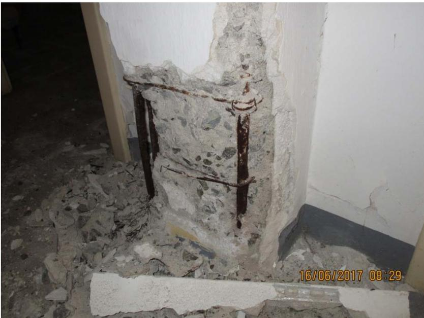
**Foto n.8:** Indagini su pilastri in conglomerato cementizio armato - rimozione intonaco e copriferro
