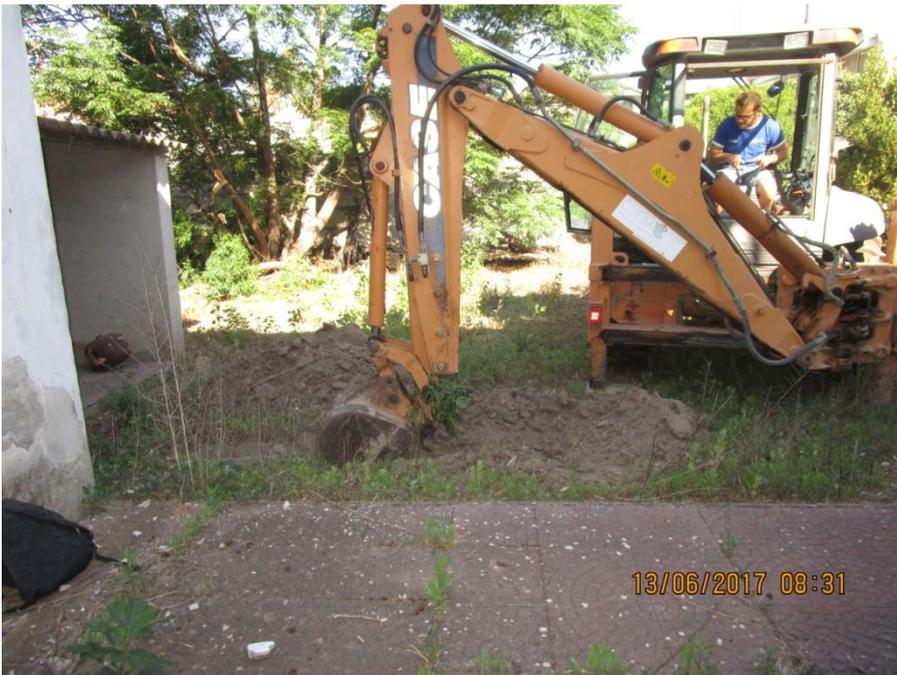
**Foto n.1:** Pozzetti di ispezione - fase di scavo
