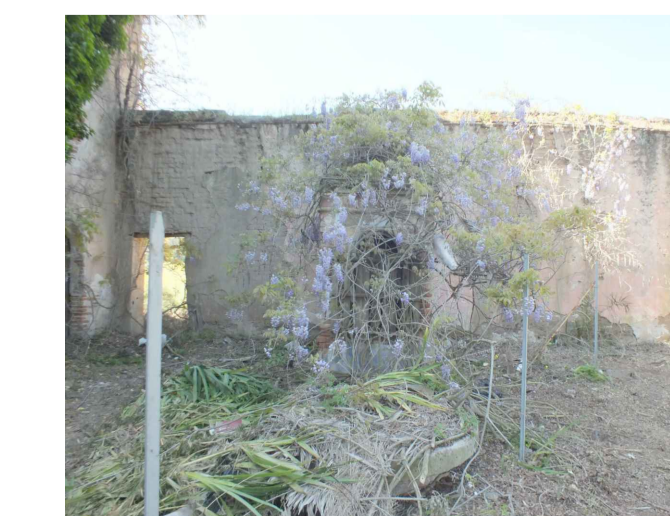
3_L'edicola voltata e, in secondo piano, il muro in fango di recinzione della corte ovest
