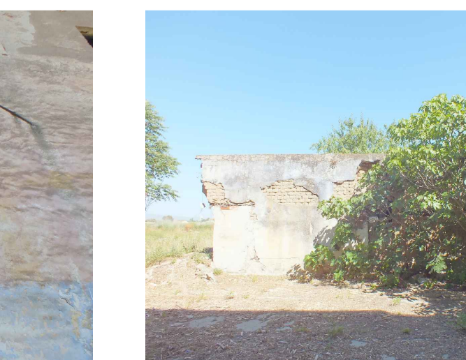
9_Muro in fango nella corte interna
