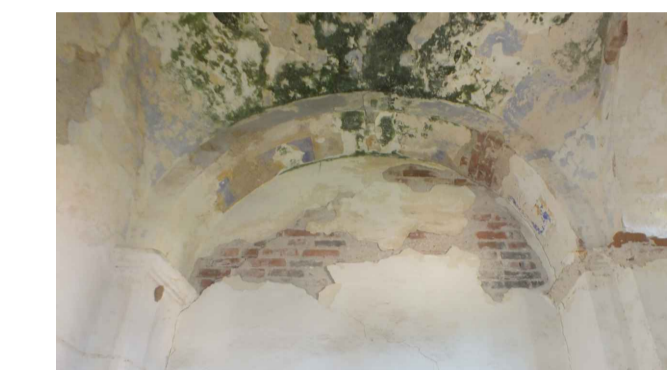
a_Piano primo, corpo longitudinale sud-ovest
