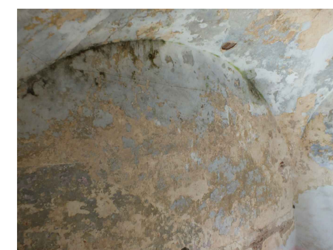
8_Distacco della fineggiatura dallo strato di finitura
