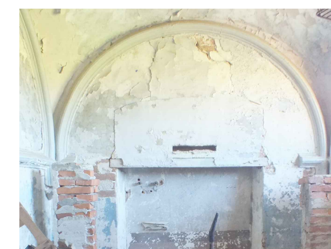
6_Distacco della fineggiatura dallo strato di finitura
