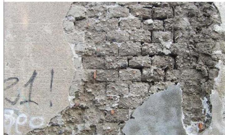
Basamento in muratura mista di pietre (basalto) e laterizi, arco di scarico in mattoni e muratura in elevazione in mattoni di terra cruda
